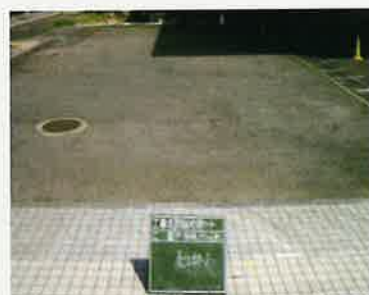
マサコートロード施工前
