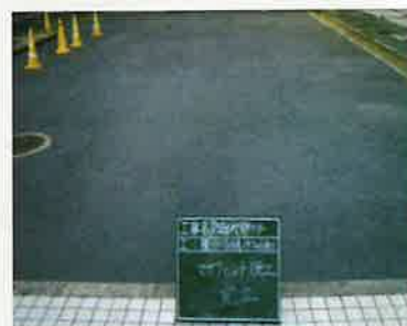
マサコートロード施工後
